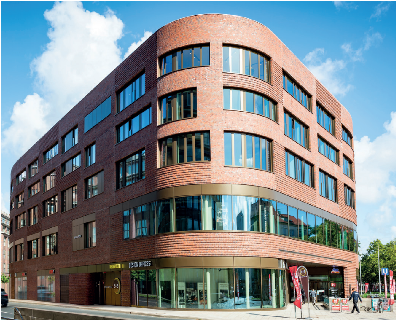
Hannover, Vahrenfalder Straße
